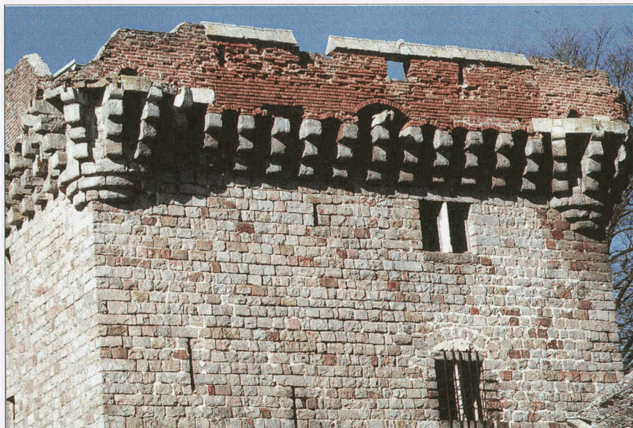
Fig. 23. Détail du chemin de ronde à mâchicoulis et échauguettes, parapet de briques et chaperon en calcaire, face sud-est. Cl. Christian Corvisier.
